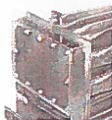
Otwory płomieniówek wymiennika po otwarciu kłapy rewizyjnej
