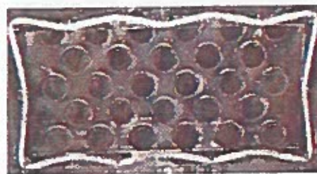
Otwory płomieniówek wymiennika po otwarciu kłapy rewizyjnej
