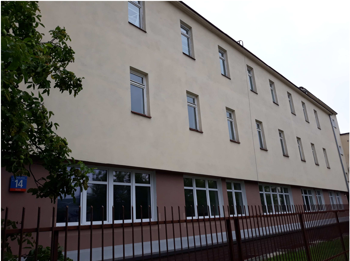
Elewacja południowa (fragment)
