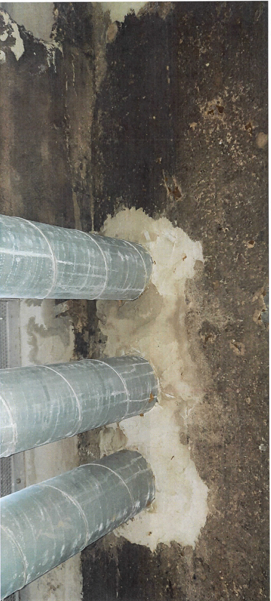
Widoczne zawilgocenia stropu przy przejściu rur wentylacyjnych oraz na nadprożu kraty wentylacyjnej
