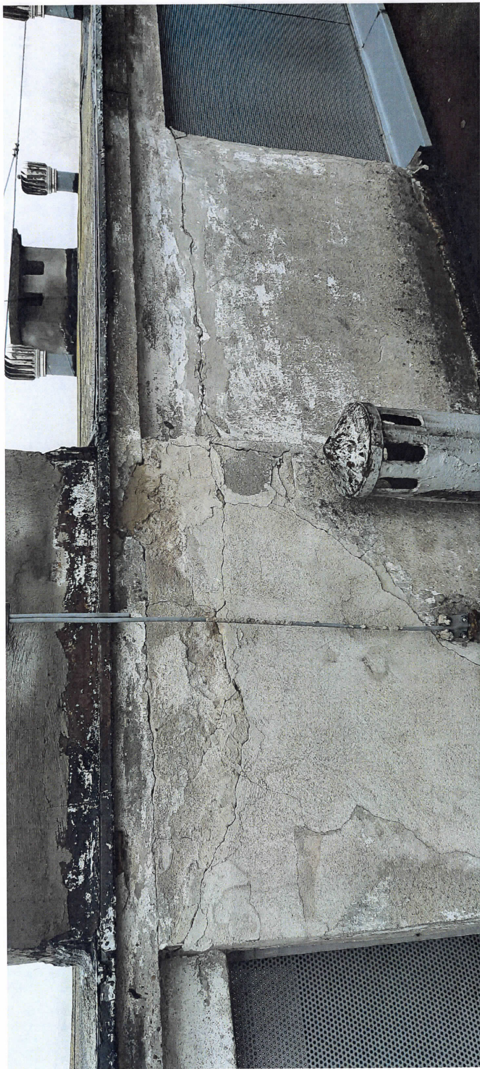
Elementy tynków filarów między kratami do zbadania odkucia i uzupełnienia
