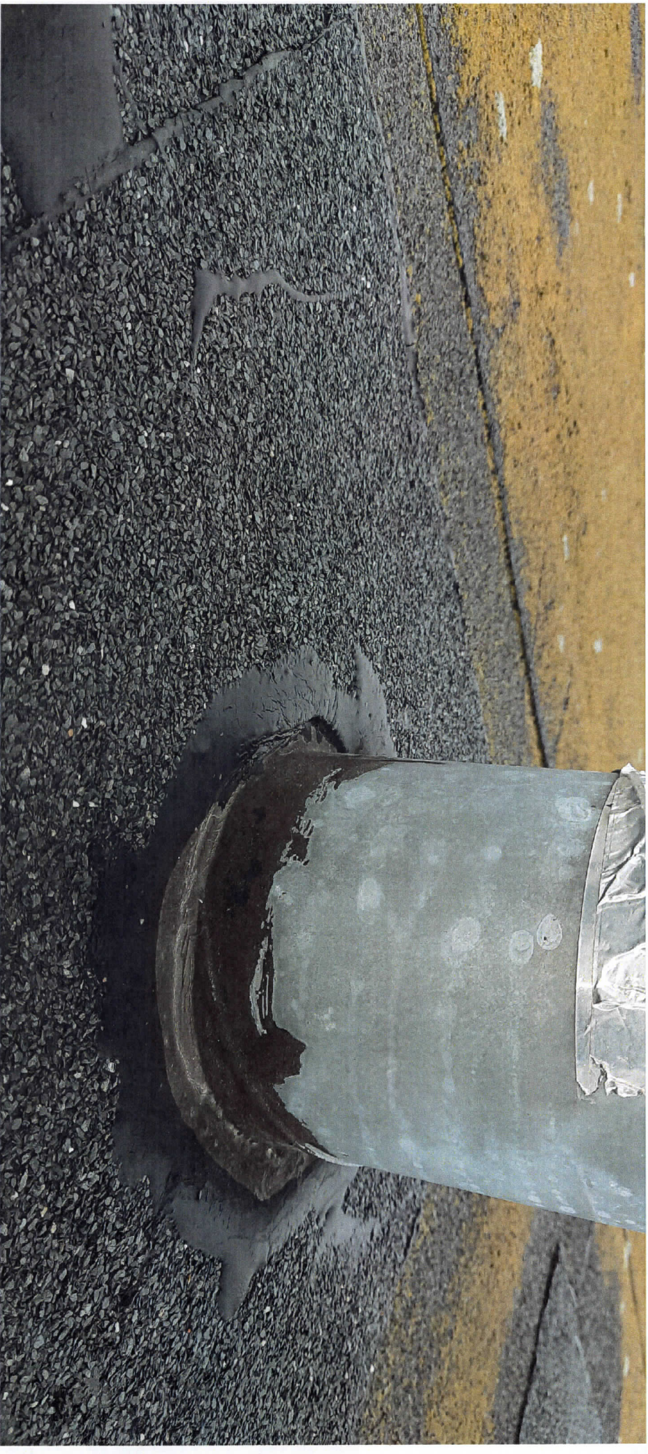
Widoczne braki w uszczelnieniu przejścia wentylacji przez dach
