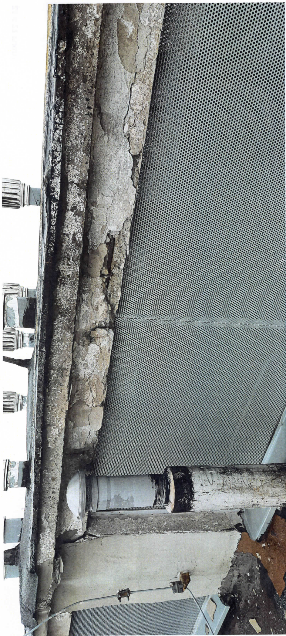
Odpadające elementy tynków nadproży krat, do odkucia i uzupełnienia
