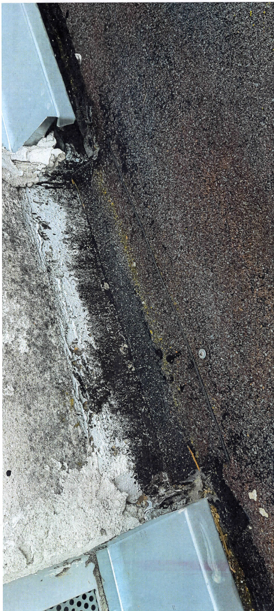
Widoczny brak odpowiedniego wywinienia izolacji z papy na powierzchni filarka między kratami
