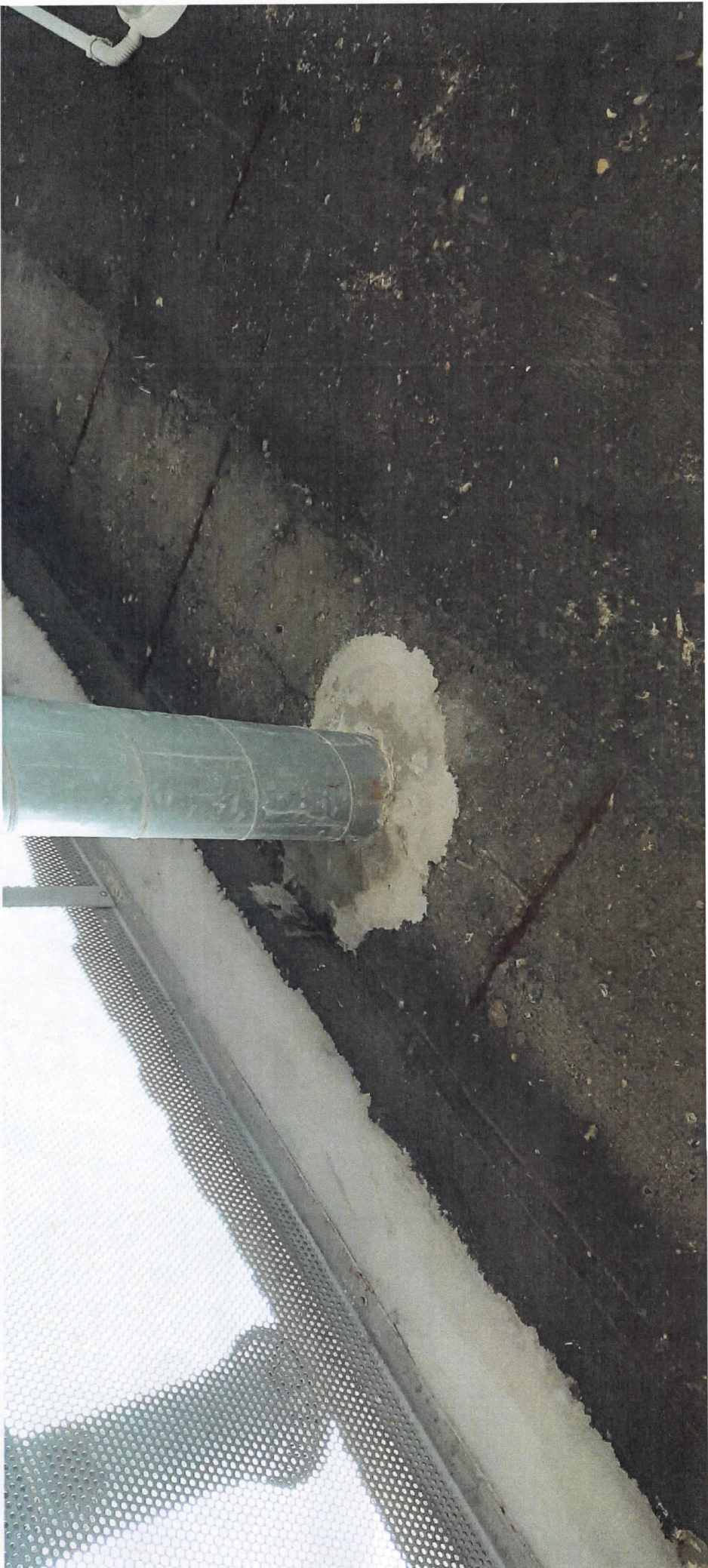
Widoczne zawilgocenia stropu przy przejściu rur wentylacyjnych
